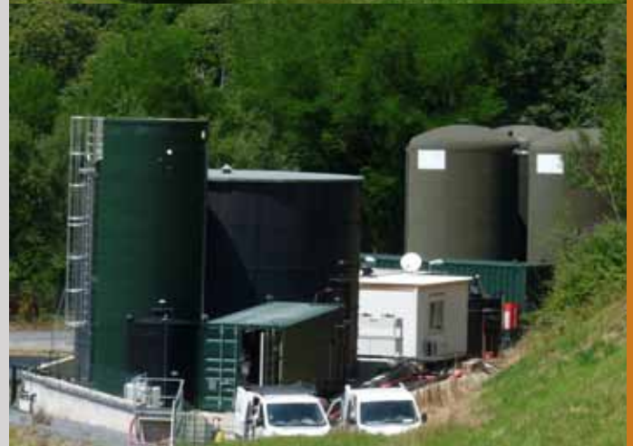
Unité de traitement des effluents liquides (Biologie et osmose)
