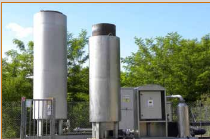
Unité de traitement des effluents gazeux (Torchère)
